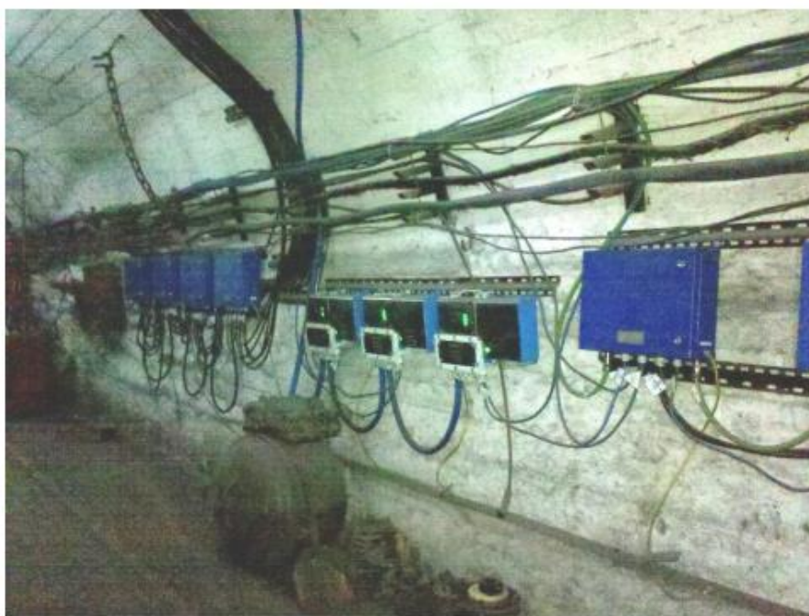
Рисунок 1.9 – Пристрої SCADA-системи підключені до оптоволоконної лінії
